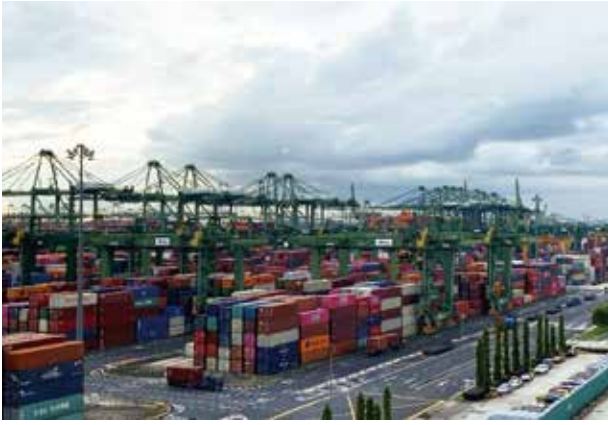
バシールバンジャン港PSAオフィス棟から南東方向の光景
