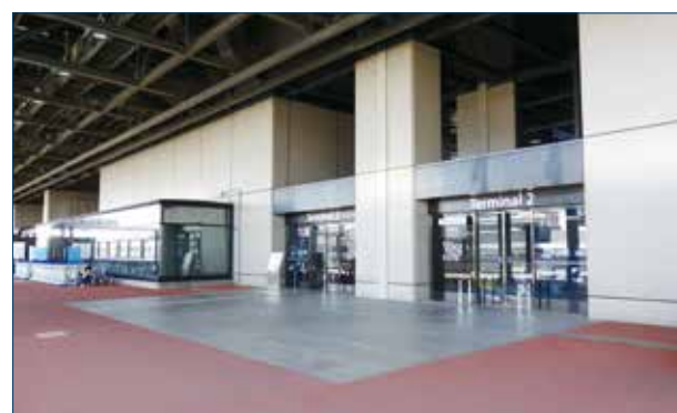
④第2ターミナル3階出発ロビー玄関口
